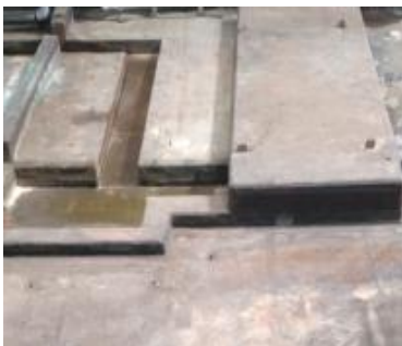
【พื้นที่ก่อนทำปรับปรุง】
