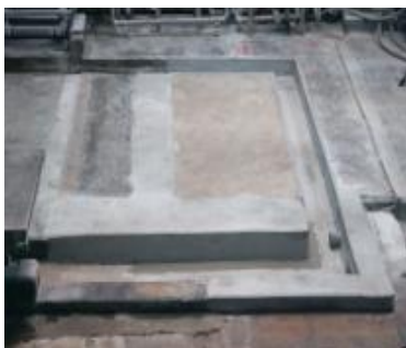
【หลังเทคอนกรีต】
