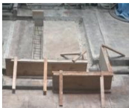
【型枠、鉄筋敷き】
