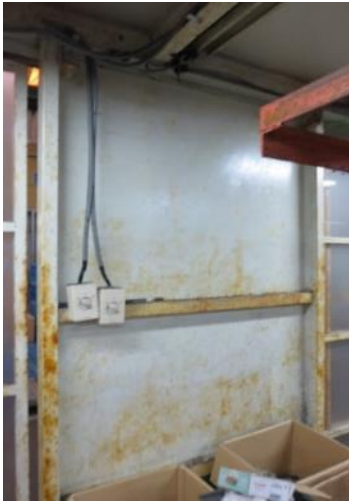
ผนังเหล็กขึ้นสนิม
