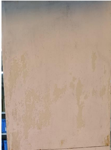
① ผนังเหล็กขาดบาง ๆ
